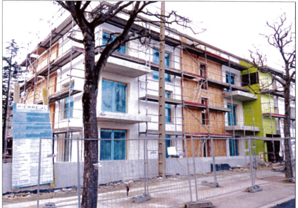
En bas du Boulevard Leroy, rive droite, ce bâtiment coloré arrive au terme de sa construction. Il disposera de 45 logements. Un bon exemple des dernières années qui ont vu fleurir de nombreux programmes projets à Caen et dans l'agglomération.
